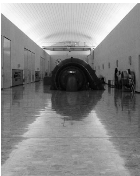
DIE KAVERNE IST 143 M LANG, 29 M BREIT UND – IM FIRST GEMESSEN – 24 M HOCH. FOTO: HANSJÜRG GREDIG
