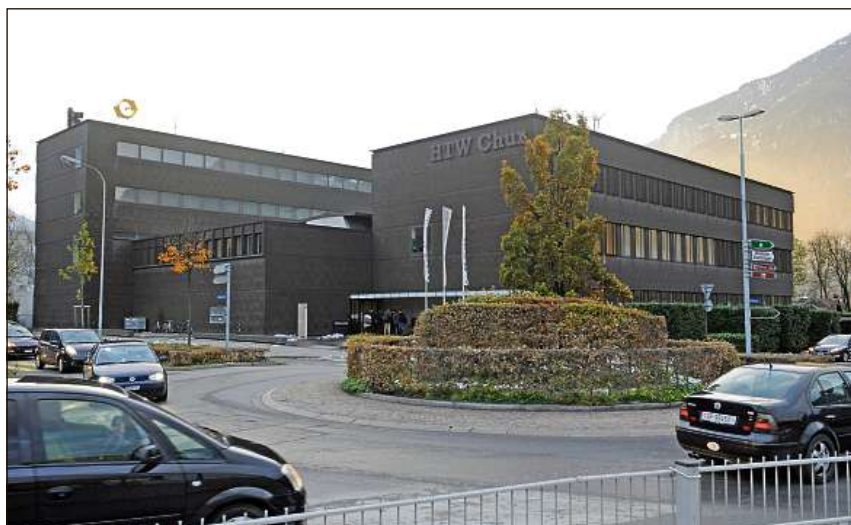
Edifiz da la Scola auta per economia e tecnica a Cuira.
